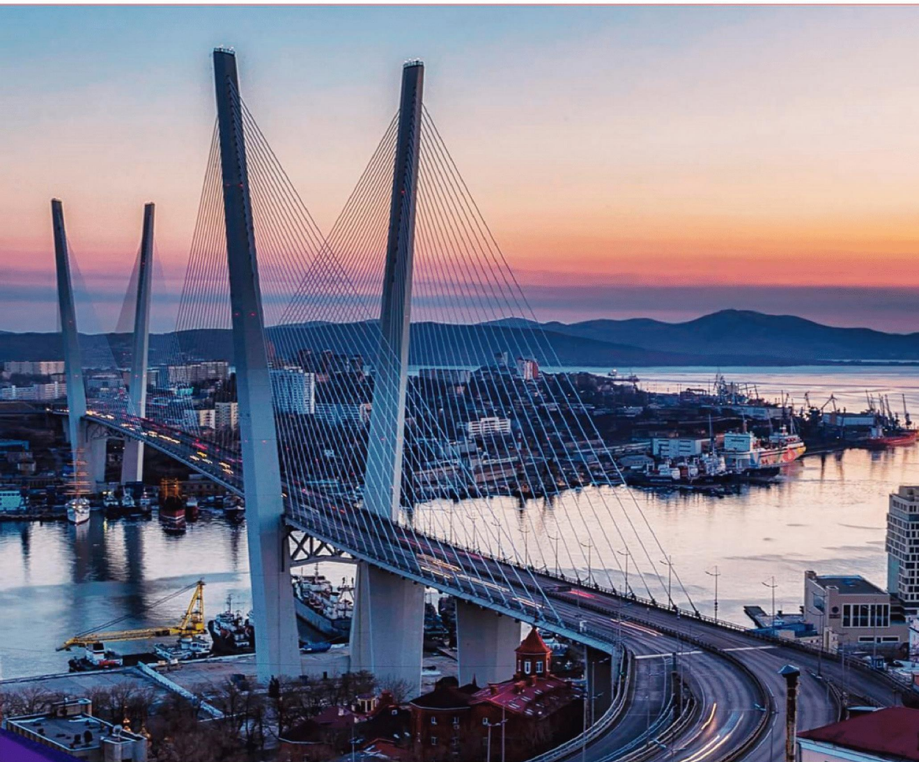
Золотой мост — вантовый мост через бухту Золотой Рог во Владивостоке
