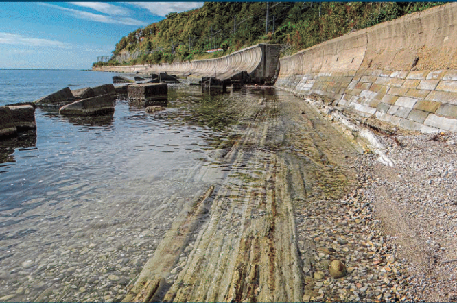
Существующее состояние берега в районе марины «Водопадная» ! - Плечи и набережные отсутствуют.
