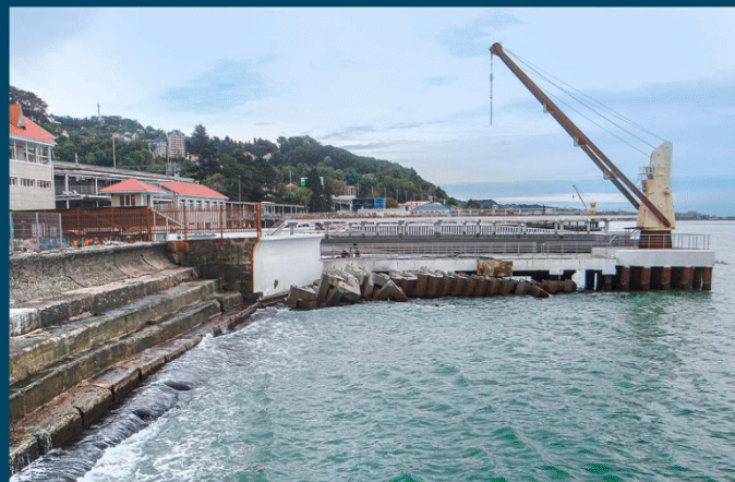
Существующее состояние берега в районе марины «Коста» ! - Узкие, размываемые штормами, пляжи или их отсутствие. ! - Набережные отсутствуют.
