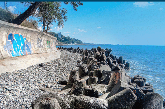
Существующее состояние берега на участке между Мацестой и Хостой ! - Пляжи и набережные отсутствуют.
