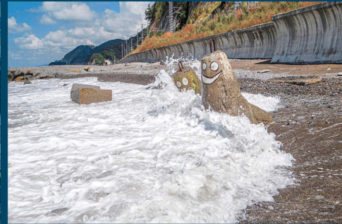
Существующее состояние берега в районе МРК «Марина «Каньон Прохладный» ! - Узкие, размываемые штормами, пляжи или их отсутствие. ! - Набережные отсутствуют.
