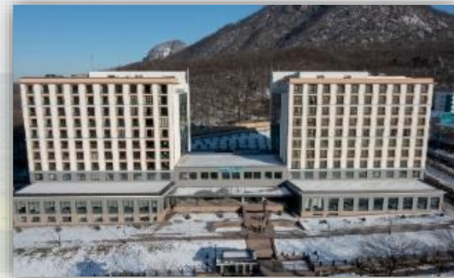
Санаторий «Источник» в г. Железноводске
